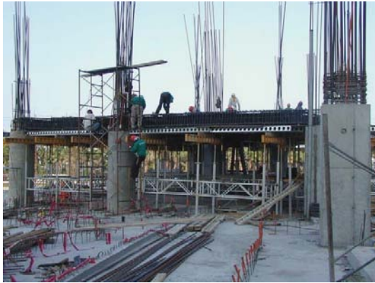
高層建物(コンドミニウム)施工例
