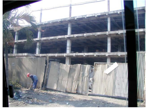
中層建物(事務所)施工例
