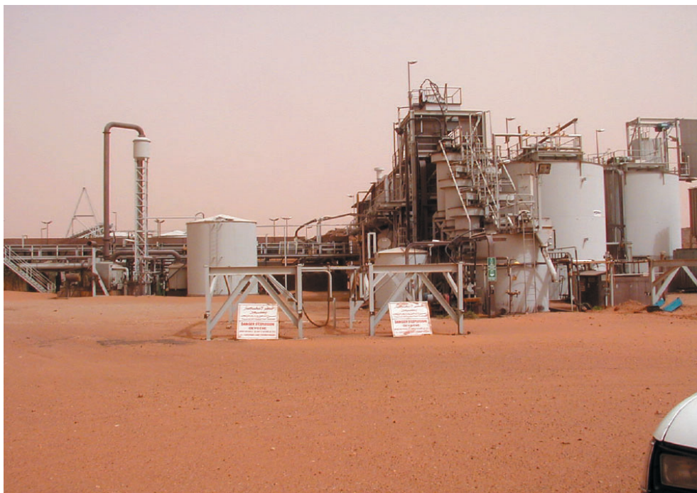
Akjoujt鉱山の尾鉱から金を回収するプラント。 （現在は稼働していない。）
