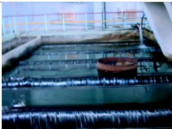
着水・薬品混和池
