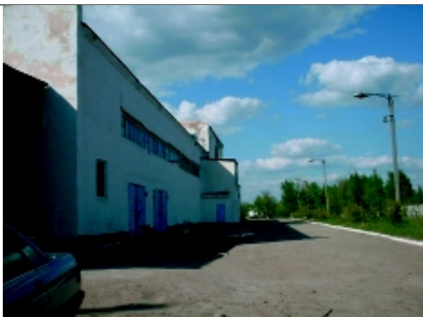
浄水場屋外概観
