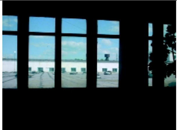
ろ過池から沈殿池の屋上を見る。 所々にマンホールがあってそこから覗いて 処理状況を確認できる。
