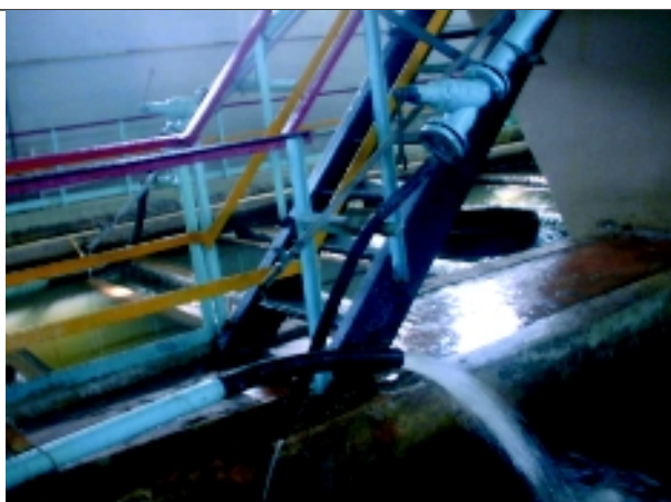
混和池の薬品注入 （中央の細いホースで硫酸バンド注入）
