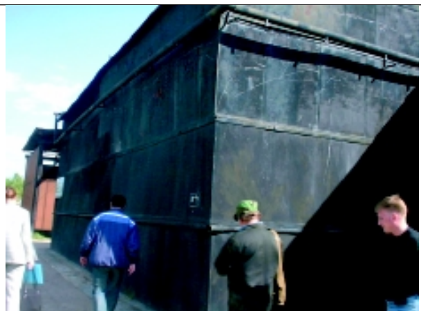
塩素ポンベ貯蔵庫
