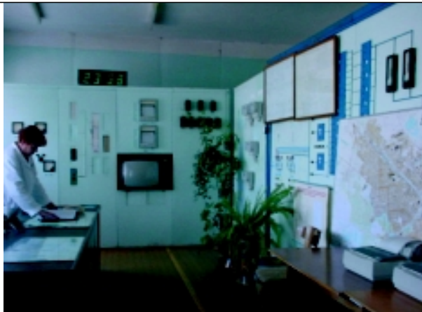
浄水場流入流出量監視室
