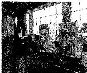
5 ボイラーシュミレーター
