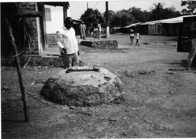
写真 No.21 一般的な伝統的素掘井戸 地表からの水の浸入を防ぐため、井戸周囲は 高上げの工夫がされている
