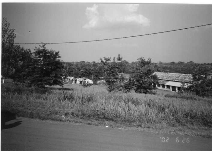
写真 No.5 M'Baiki 市（電化）遠景 1969 年に公共用発電機を導入
