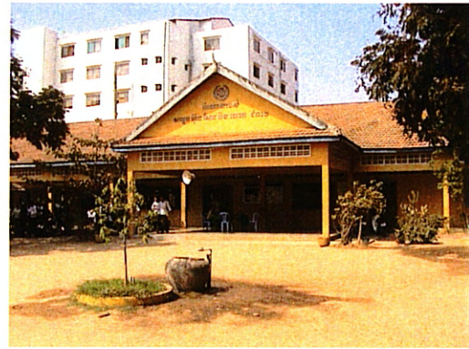
建設予定サイト (1) (解体予定の既存管理棟。施工不良により危険な状態にある)
