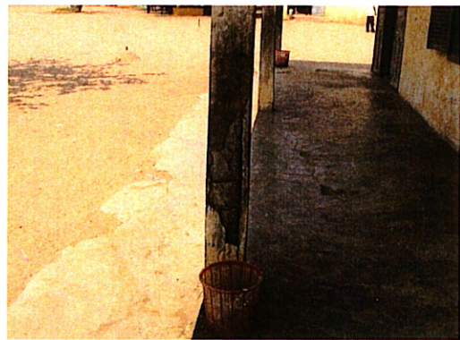
上記解体予定校舎の柱
