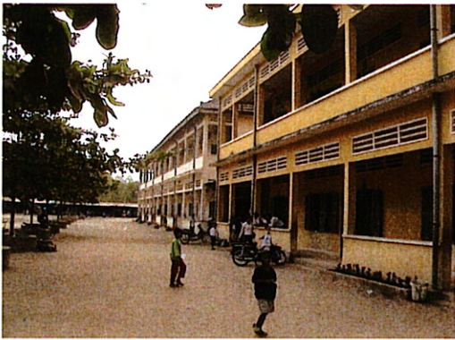
既存校舎外観
