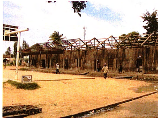
建設予定地 (既存老朽化教室は撤去が開始済み)
