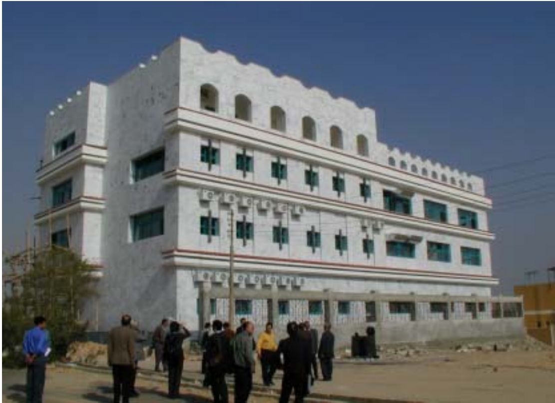
写真 No.1 アシュート RBO (上屋全景)
