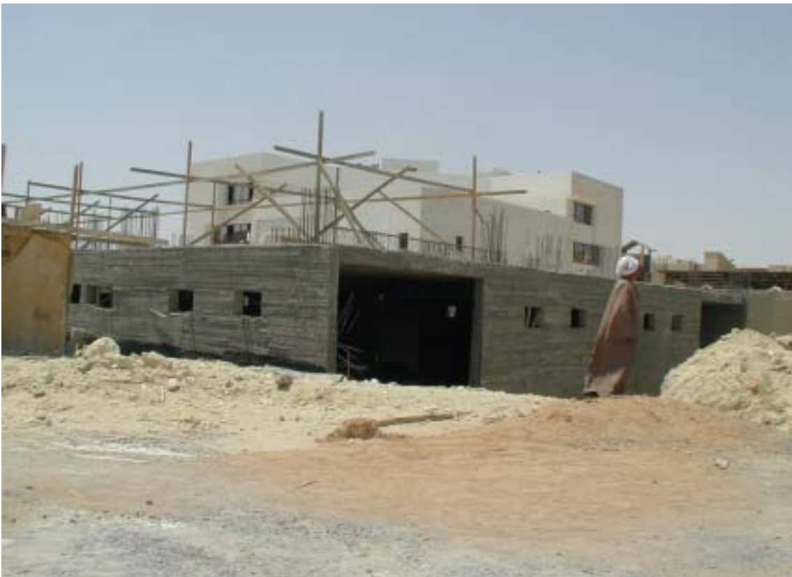
写真 No.6 ハルガダ RBO (上屋全景)
