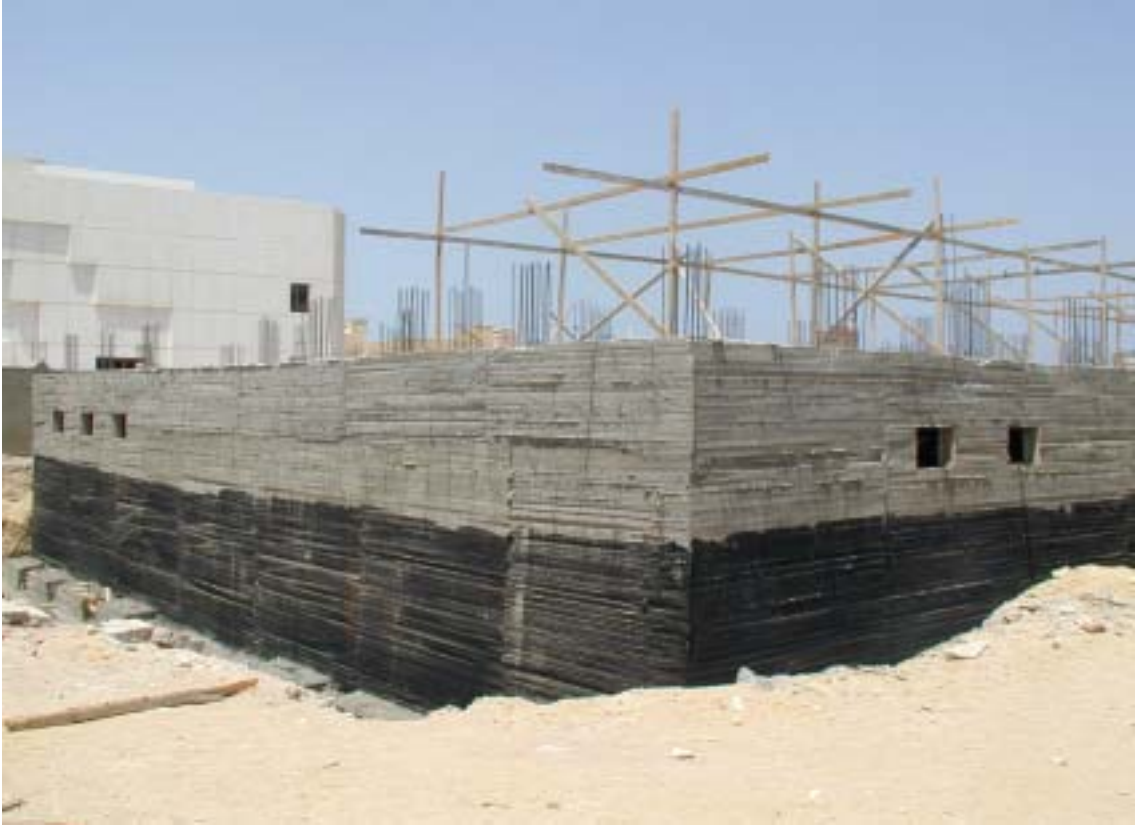
写真 No.5 ハルガダ RBO (上屋全景)
