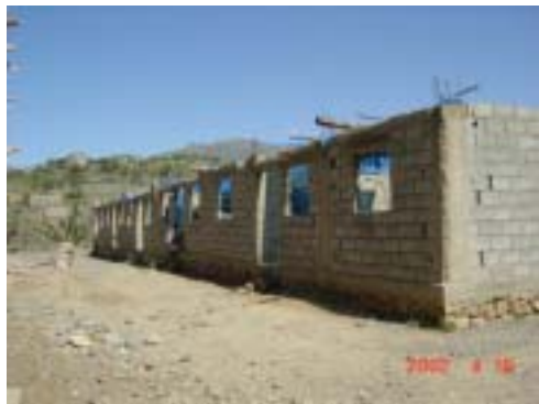
TZ-01 Al Ihsan-Damnah Khaeer校 父兄の仮設教室は資金不足で屋根なし。
