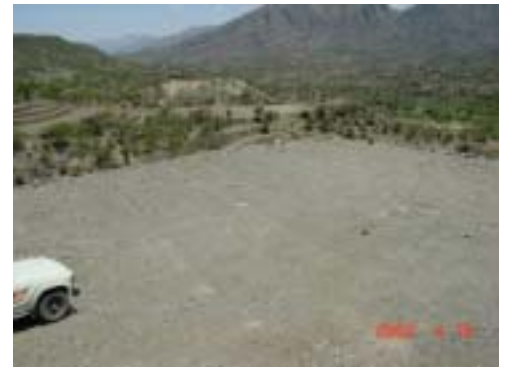
TZ-17 Al Fath Al Uzlah 校 500m程離れた建設サイトを造成済み。
