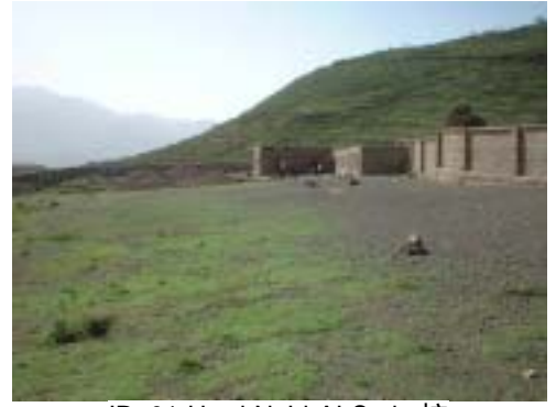
IB-01 Hard Najd Al Sadm校 建設予定地。敷地内で基礎穴あり。
