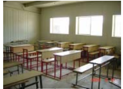
世銀プレハブ校舎 教室内部、窓サッシュがない。
