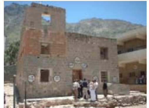
TZ-16 Al Fawz 校 この旧校舎を撤去して建設する。
