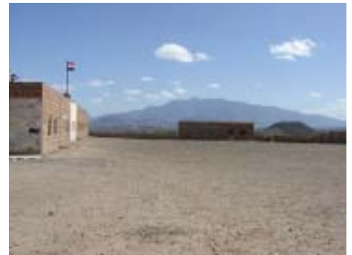
TZ-13 Maud Bin Jabal-Al Gherrama校 敷地内の建設予定地。
