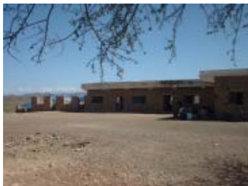
TZ-02 Ad-Demnah女子校 既存校舎と左端に仮設教室がある。
