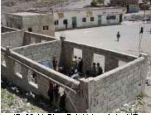
IB-06 Al-Diya-Bait Yahya Aubadi校 既存校舎。仮設教室は屋根がない。
