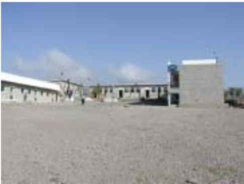
KfW: 左が改修、右が増築
