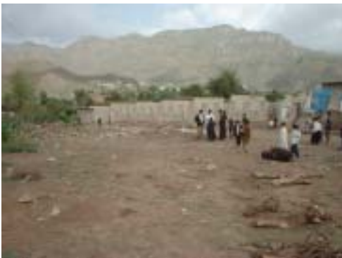
IB-10 Al Usama Bin Zaid校 既存校舎は屋根がない。
