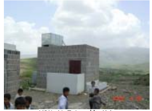
KfW: Al-Falooq校、Ibb 便所、標準設計で水洗用給水がない。
