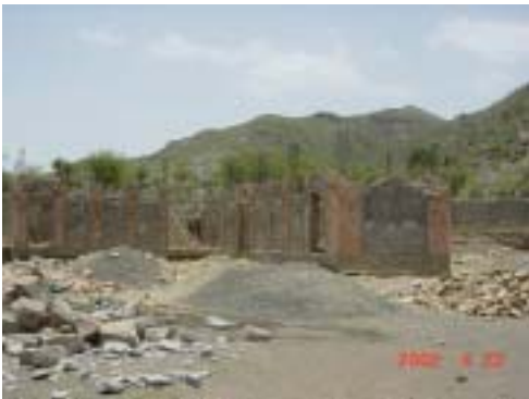
社会開発基金(SFD)の標準設計 RC 2階建て、外壁は切石貼。
