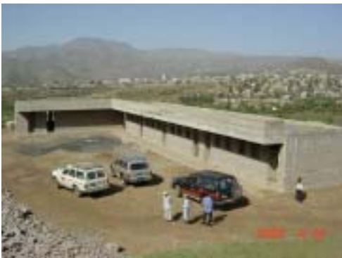
IB-19 Al Ra'eeyah校 既存校舎、まだ工事中。
