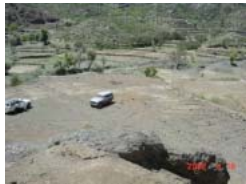
TZ-01 Al Ihsan-Damnah Khaeer校 建設予定地は斜面を切って整地済み。
