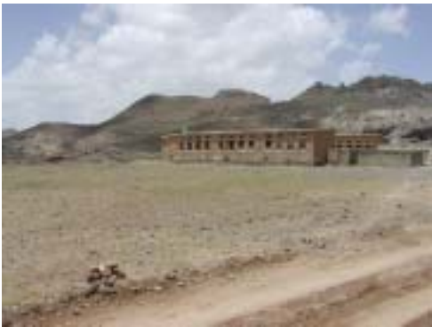
IB-18 Al Aemen School-Thafer校 舗装道路に近いが、必要教室数が少なく削除。
