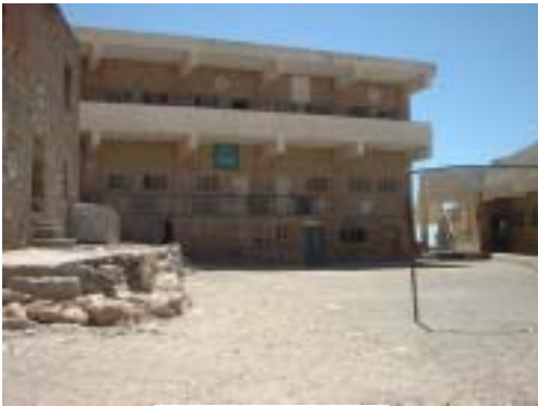
TZ-16 Al Fawz 校 既存校舎が建て込んでいる。
