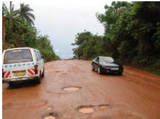
1.8km 地点の路面状況
