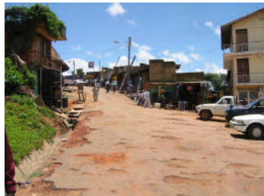
終点部 9.1km 地点の路面状況
