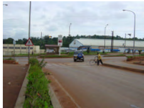
ポートベル交差点（1期工事） 安全施設として、街灯・路面表示・歩車道 分離が設置されている。
