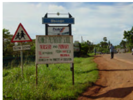
学校近傍（ガバ道路） 標識の設置はあるが、安全対策工（横断歩 道等）が不十分である。
