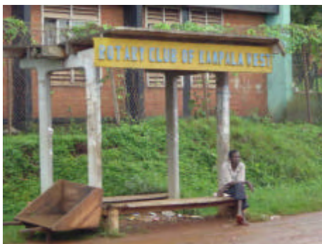
バス停留所（ナテテ道路） バス停車帯が設置されていないため、交通 が阻害されている。
