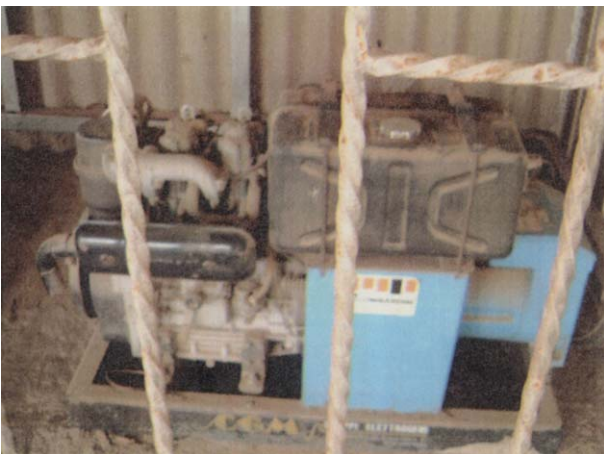
ウォークイン冷凍室用発電機
