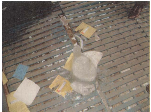
ウォークイン冷蔵庫の内部。濡れた水が氷結している。
