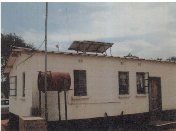
Chipapa 保健センター (人口 7,520 人をカバー) 屋根にソーラーパネルが取り付けられている
