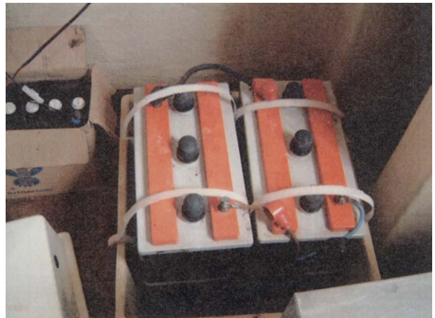
ソーラーシステムのバッテリー
