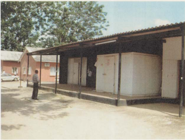
ルカサ市中央倉庫のウォークイン冷凍冷蔵庫
