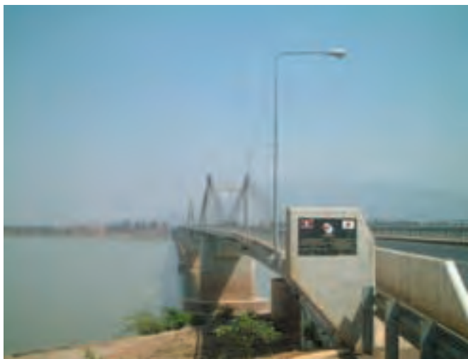
無償資金協力で建設されたバクセー橋（ラオス）
