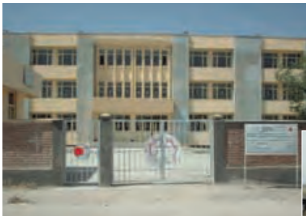
アフシャール女子学校の改修前と改修後
