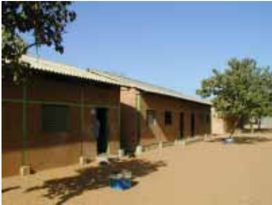
Photo N° 1 Une école publique urbaine. Le bâtiment est construit en profitant le maximum d'un terrain limité.
