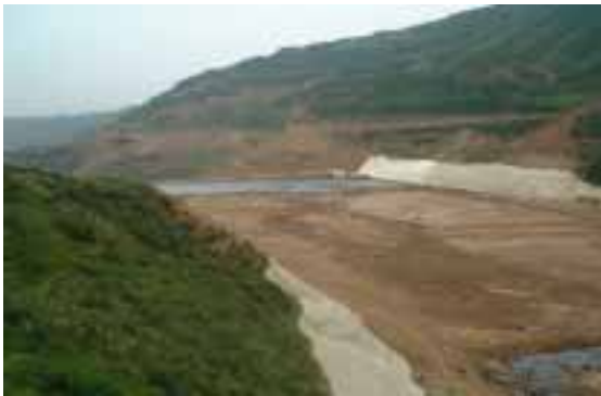
埋立区画の下流側（防水シート・覆土施工済み）
