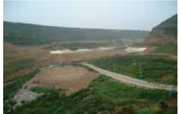
第二期区画の下流側からの全景
