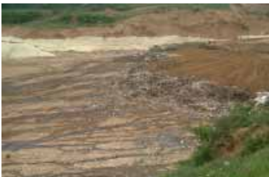
埋立区画の前面（ごみ転圧による浸出水の流出）
