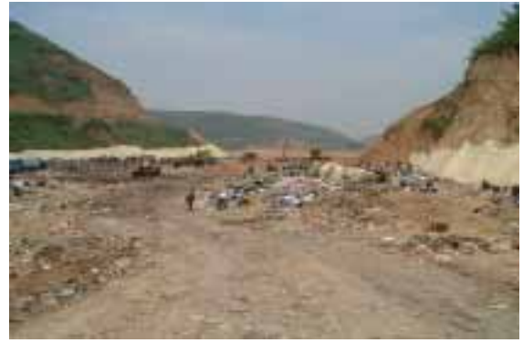
第二期工事の埋立区画
