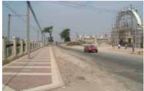
江村溝処分場へのアクセス道路 - 2 (迂回路建設中)
