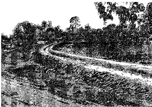
同水利組合メンバーが労務提供して建設した 幹線水路。水源はメキ川よりポンプ揚水。
