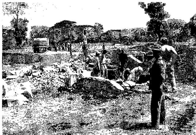
同灌漑スキームの排水路工事。
