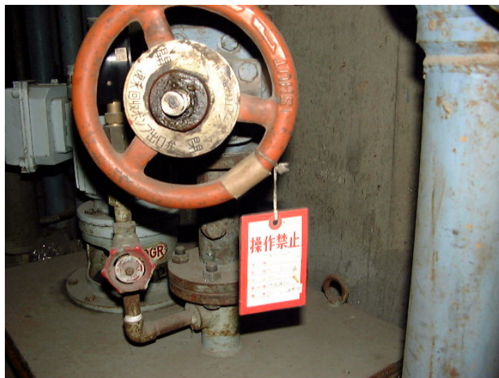
Fig 6.2-5 弁・ダンパロック管理札
