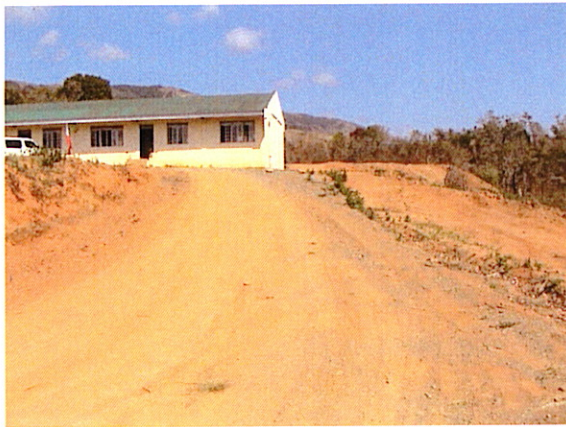
S-54 (S-87) CARRANGLAN HS (Annex A-Digdig)
