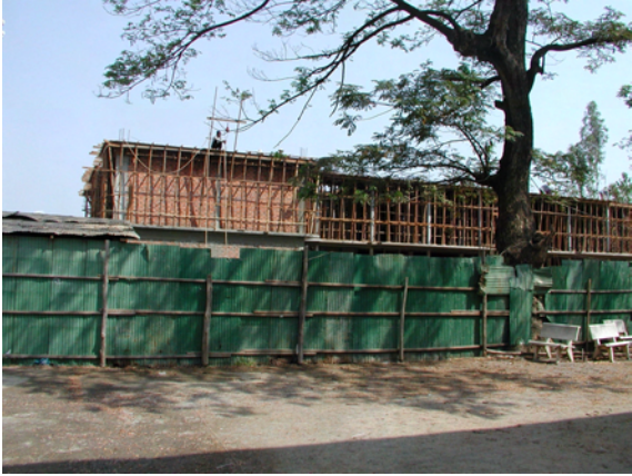
建設中の薬学部
