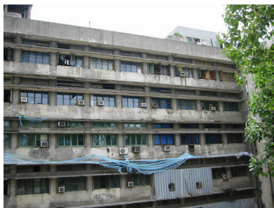
市婦幼保健院：旧產科棟
