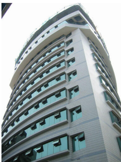
重慶市婦幼保健院：新綜合病棟
