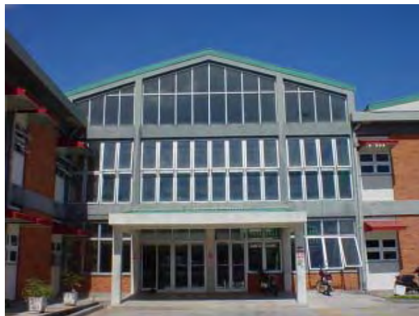
ジョージタウン国立病院中央診療棟入り口 (米州開発銀行の融資により建設された。)
