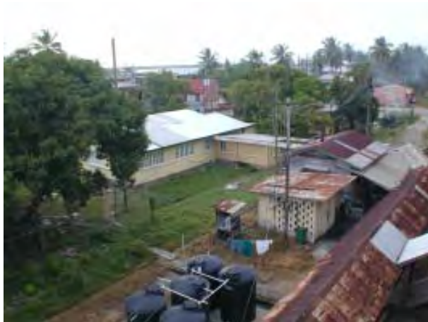
過去に給水設備の改修を試みたが成功せず、タンクだけが残っている。(黒色のタンク5基)
