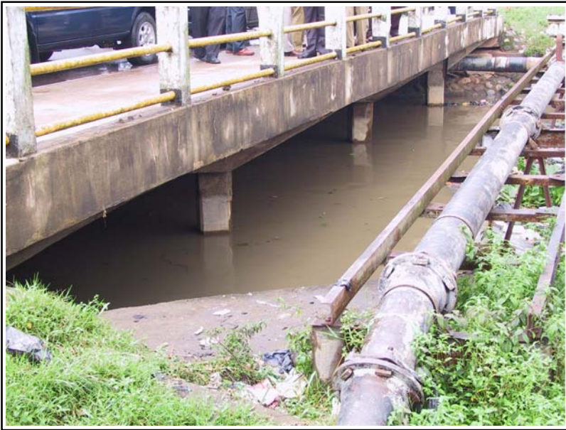
パレンバン市1次排水路、水位上昇のため橋梁余裕のない桁下
