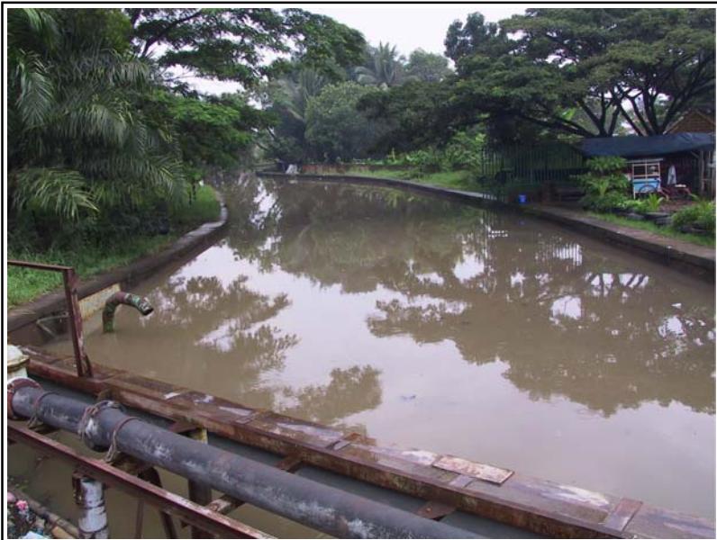
パレンバン市1次排水路道路
