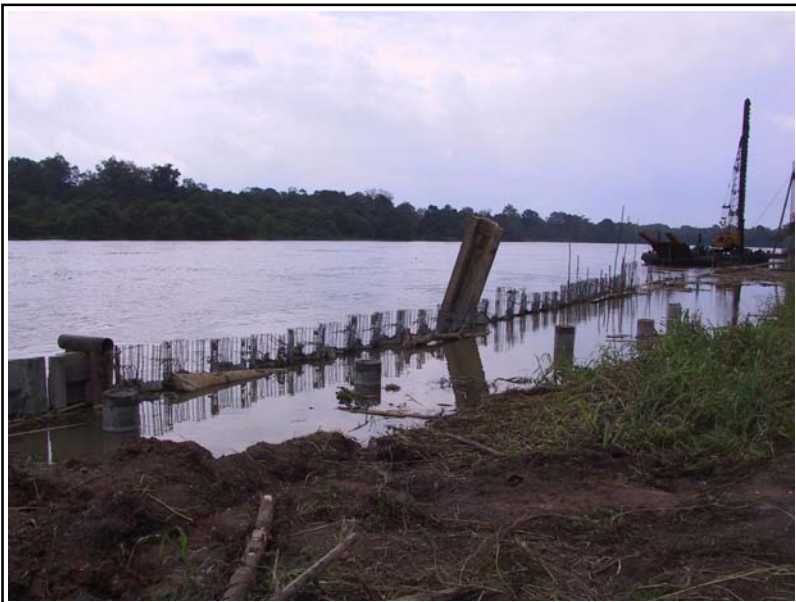
ムシ川中流・護岸工事
