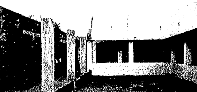
■ テンドックタ B-PHC：現在建築中である。柱筋が細く本数も少ない、梁との剛性が期待できない構造である。
