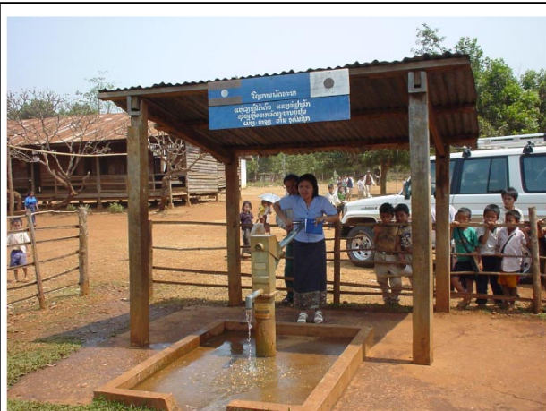
手押ポンプ付深井戸給水施設 (無償による事業化)
