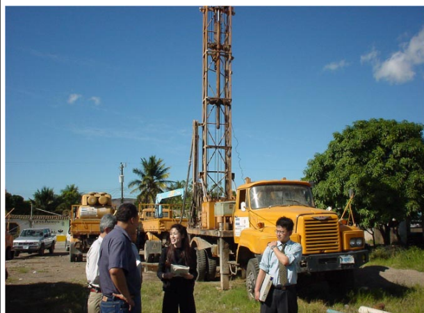
無償資金協力で調達された井戸掘削機維持管理と技術移転について関係者へのヒアリング
