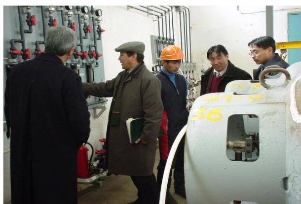
ウランバートル市水道局 送水場内の視察 (無償資金協力で事業化)
