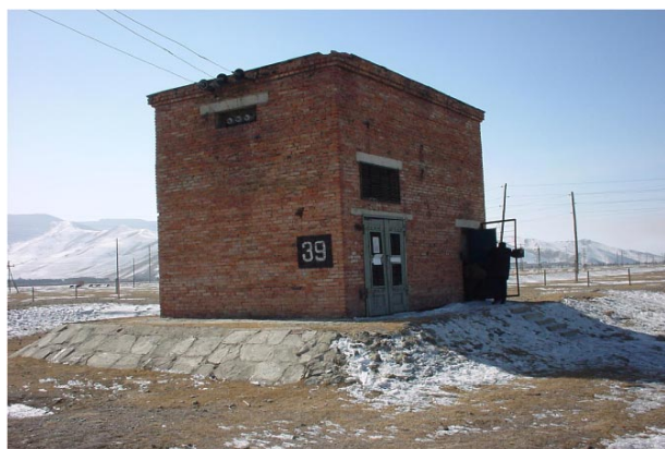
水源井施設(ウランバートル中央) (無償資金協力で事業化)
