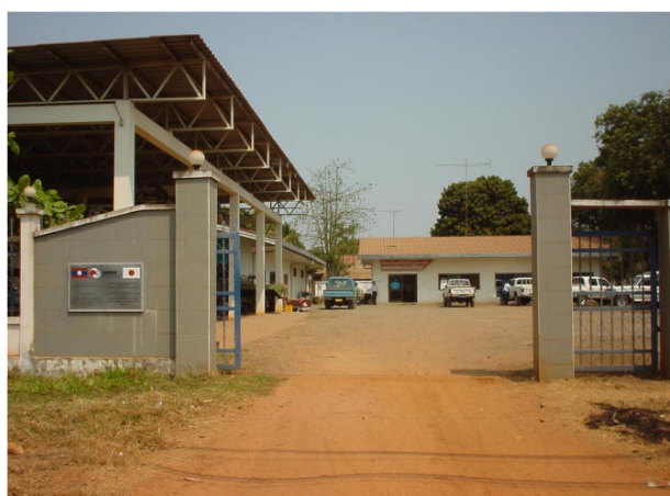
無償資金協力で建設された維持管理センター (チャンパサック県)
