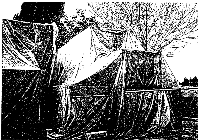
写真 - 4 . 実験場建設サイトでの供与機材の保管状況
