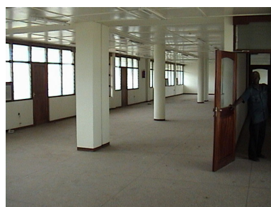
新棟 2F 事務所スペース
