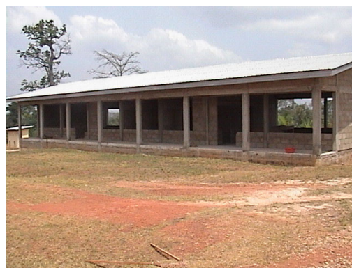
建築中外科棟
