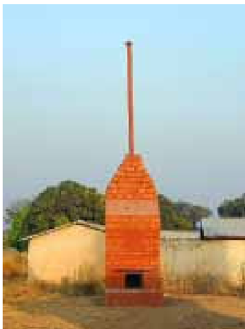
焼却炉 使用済みの注射器など、医療廃棄物を処理する
