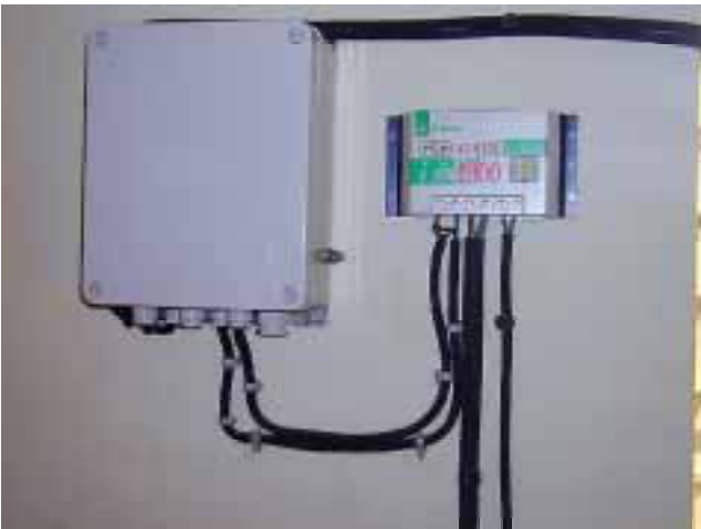
ソーラーエネルギーにて稼動している
