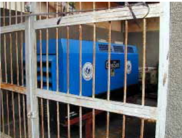
発電機 20KVA コールドルームのバックアップ電源
