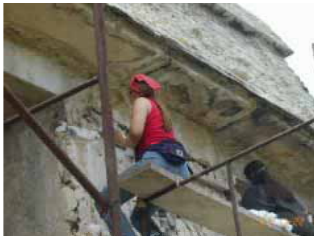
パレンケ遺跡保存作業現場
