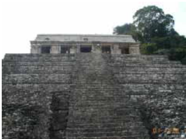
パレンケ遺跡保存作業現場
