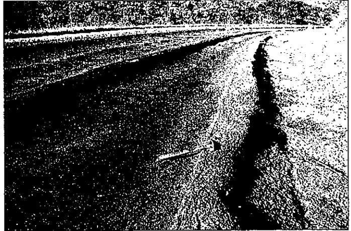
アスファルトの流動化 山側側溝の通水断面は閉塞されている
