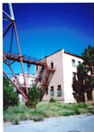
ウランバートル放送会館 2 階部分に STL 装置が収納され、屋上にアンテナが設置されている。
