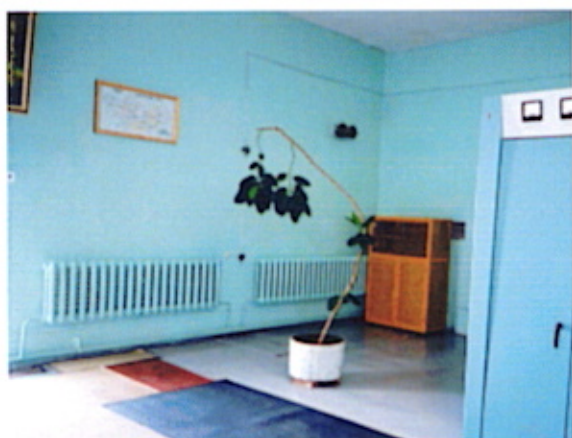
ムルン送信所 新設 10kW 短波送信機の設置予定場所
