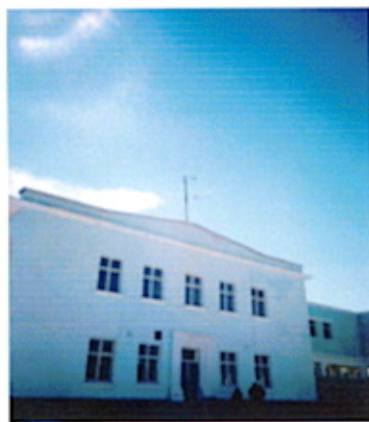
ウランバートル送信所 2 階部分に STL 装置が収納され、屋上にアンテナが設置されている。
