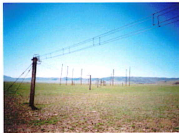
アルタイ送信所 短波アンテナ。本プロジェクトの実施に伴い 撤去される。
