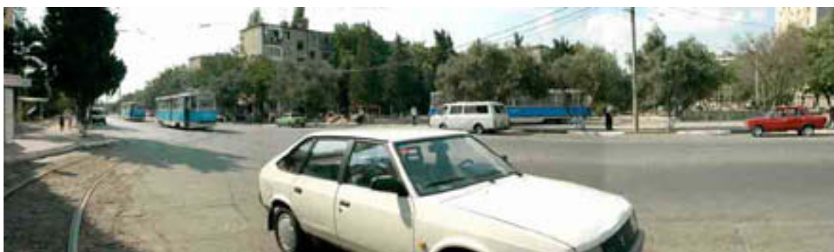
Фото 14.2.10 Терминал трамвайной линии на ул. А. Маггеррамова
