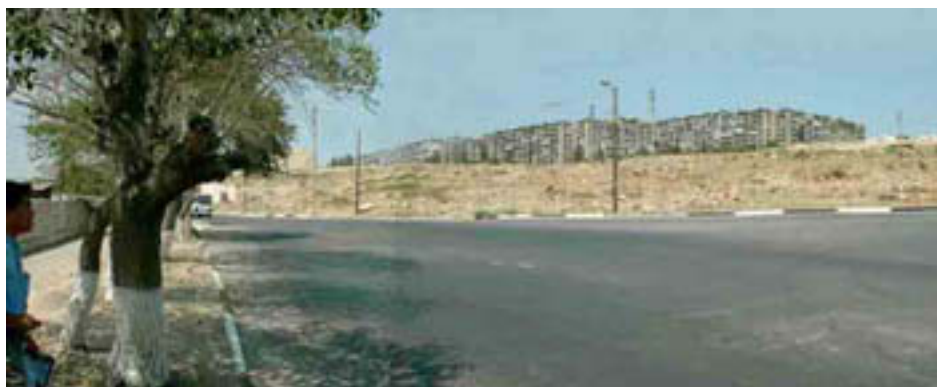
Фотог 14.2.7 Участок, предлагаемый для строительства автобусного терминала
