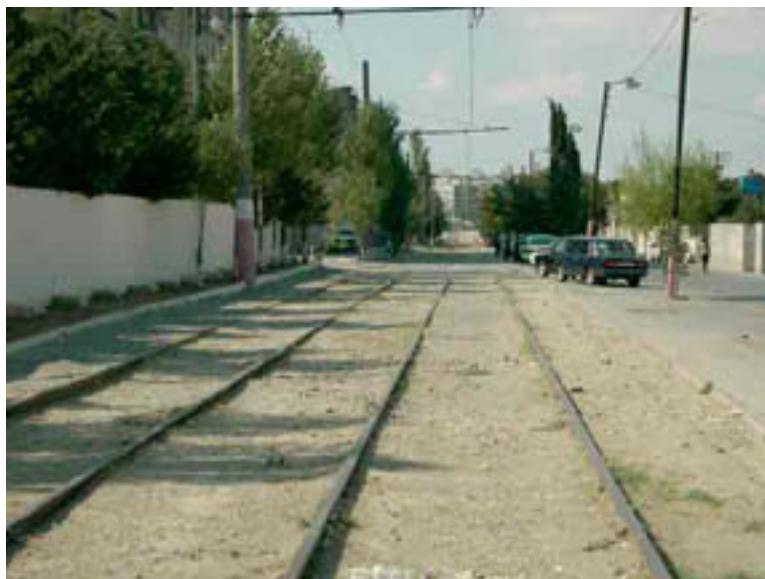
Фото 14.2.11 Обстановка вдоль трамвайной линии
