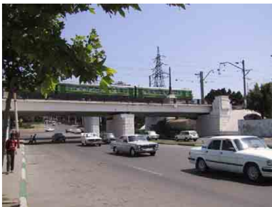
Пересечение дороги и железнодорожной линии
