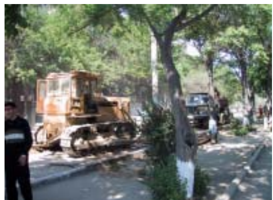
道路補修状況
