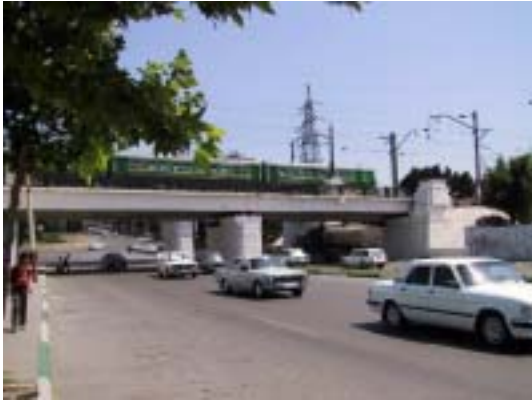
道路と鉄道立体交差
