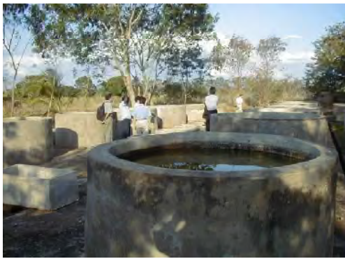
■モロゴロ州の国立養殖センター。敷地内にはコンクリート池が 29 面（直径 1.5 - 3 m）及び素堀池 1 面 200 m 3 があるが、機能していない。
