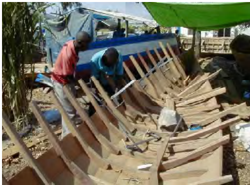
■零細漁船の建造風景。隣国のケニアやウガンダと比べ板材が小さい。
