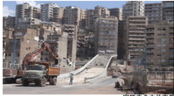
実施中の立体交差
