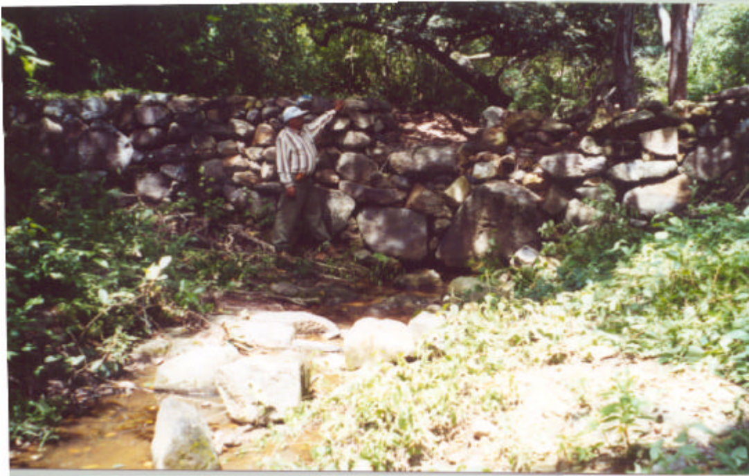
Foto I.5.4 Micro-presa de SABO de Albañil Seco ya llenada (Al=2m, L=12m) construida por SANAA en el Area de la Represa Concepción.
