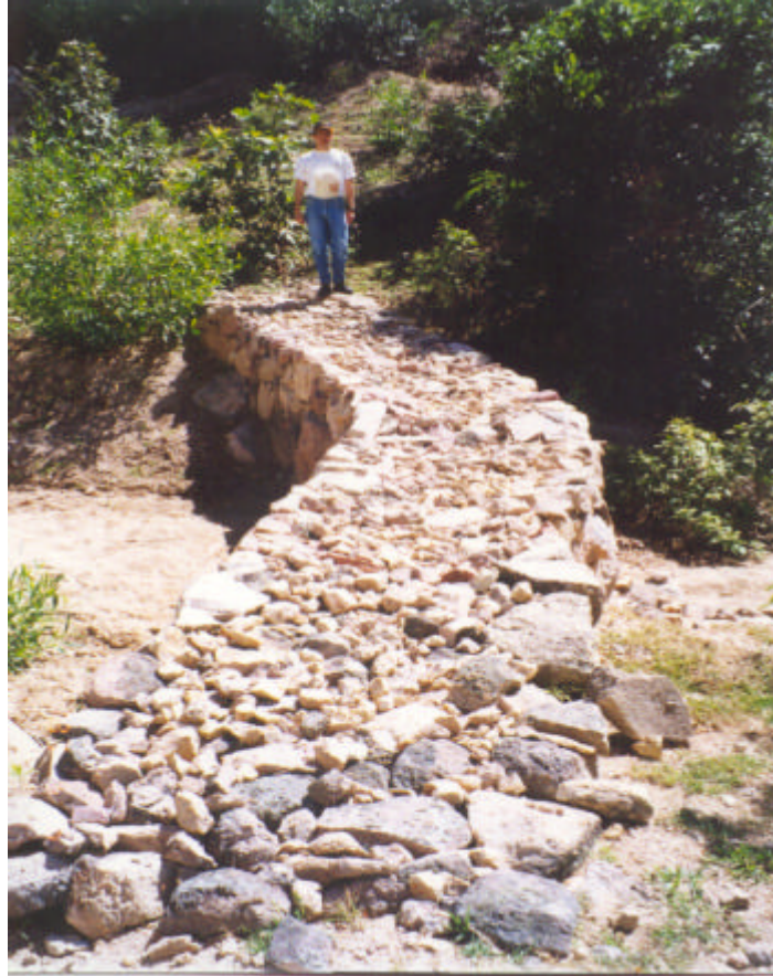
Foto I.5.3 Micro-presa de SABO de Albañil Seco Recientemente Construida (1993) en el Area de la Represa Concepción.
