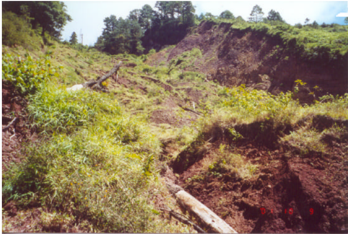
Foto I.5.1 Deslizamiento de Tierra en la Quebrada Santa Elena Producido durante el Huracán Mitch. (150mx50m). Se convirtió en un flujo de arrastre que destruyó varias infraestructuras.
