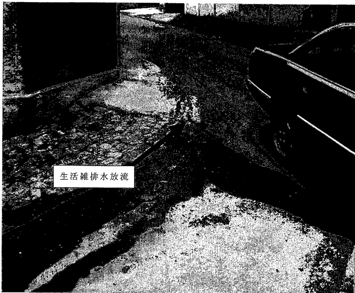
写真 1－1 生活雑排水道路放流状況
