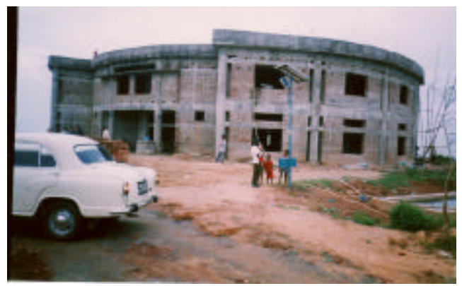
建設中の湿地研究センター、Chandrapur
