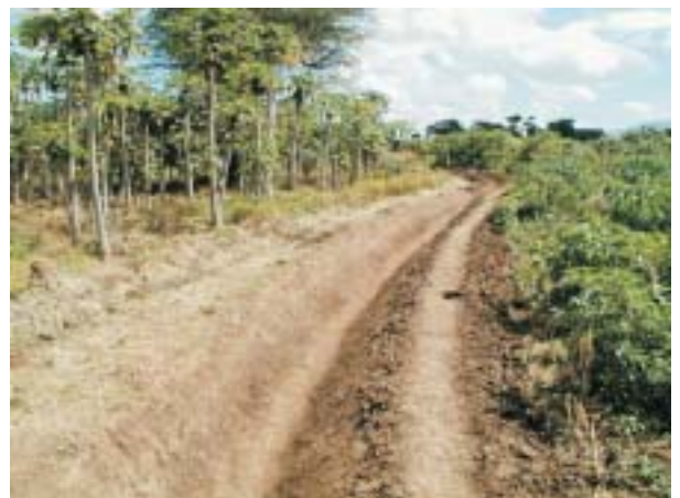
完成した水路
