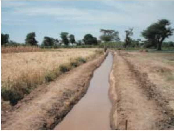
水路通水試験
