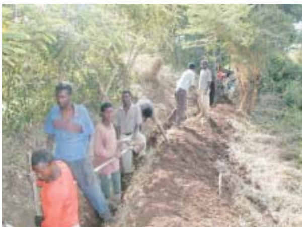
農民による水路掘削
