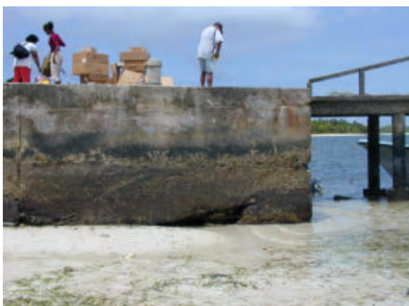
写真 - 2.2.6-1 棧橋先端部の側面の状況
