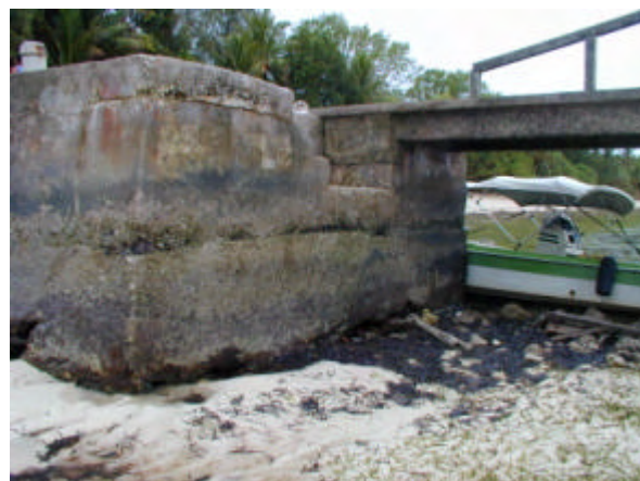
写真 - 2.2.6-2 棧橋先端部の前面の状況
