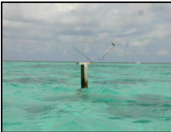
写真 - 2.2.3-3 被災したマーカー
