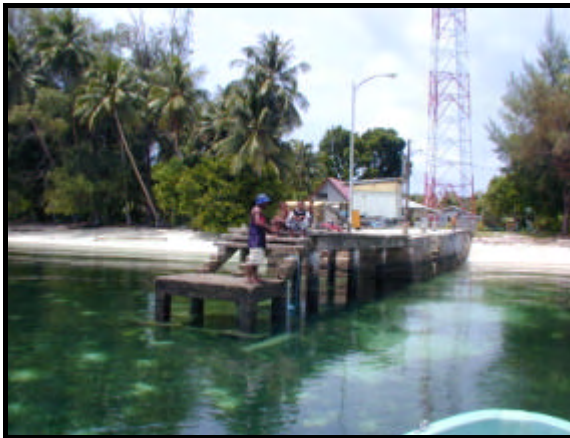
写真 - 2.2.3-1 既存棧橋及び周辺部の状況
