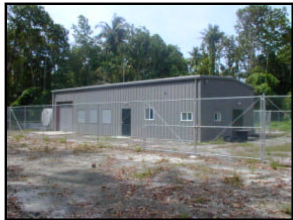
写真 - 2.2.3-2 新発電施設の状況
