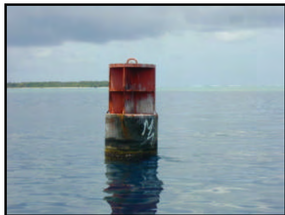
写真 - 2.2.3-4 航路標識ブイ（被災前）
