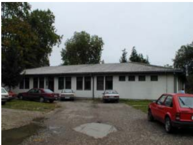
CBR センター外観 (コザルスカ・ドゥピツァ： 施設の部分的な改修が必要)
