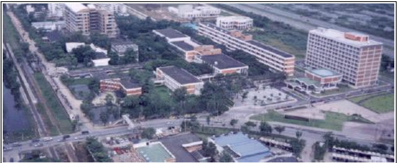
モンクット王ラカバン工科大学工学部全景
