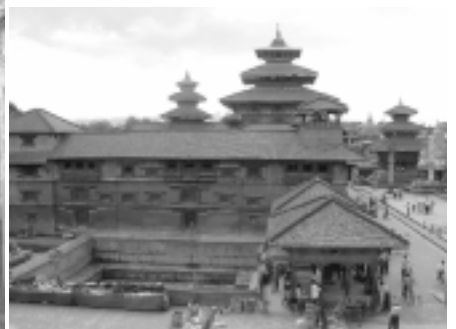
ラリットプール市ダルバール広場 手前左は水利施設、右は屋根付溜まり空間
