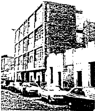
3階・4階の増築
