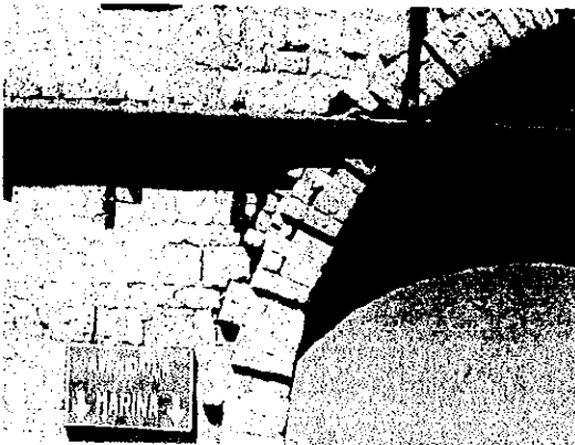
写真 2-1-6-1 アーチ部分の緩み アーチ表面とその他の石積みの中で 緩みが見られる。
