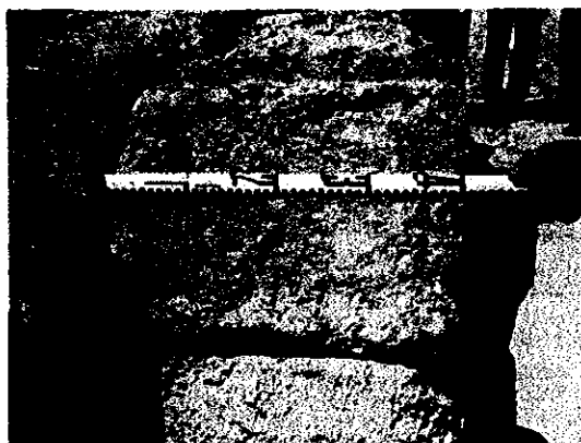
写真 2-2-7-2 使われているアドベの大きさ アドベの壁厚は Centro 地区に比べて薄い
