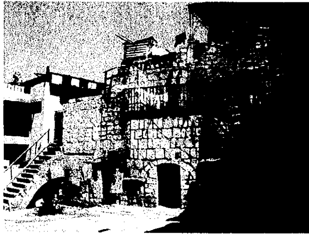
写真 2-1-8-2 1階及び2階部分の外観 石造やれんが造。地震による大きな被害はないが構造的劣化が見られる。
