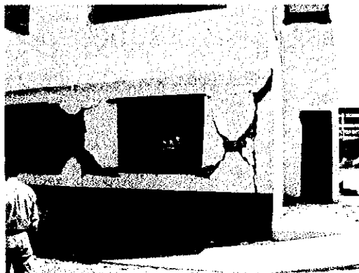
写真 2-2-3-2 CB壁と柱の被害
