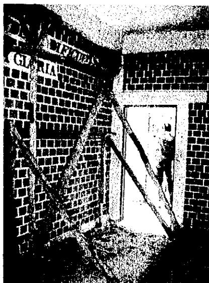
写真 2-3-7-3 被害を受けた壁 応急的支持
