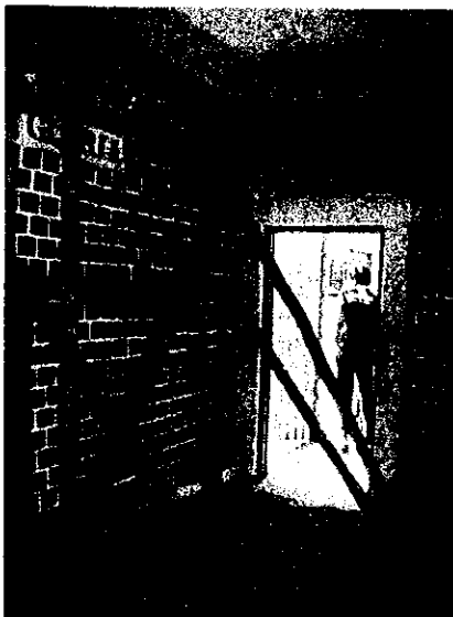
写真 2-3-7-3 被害を受けた壁 応急的支持
