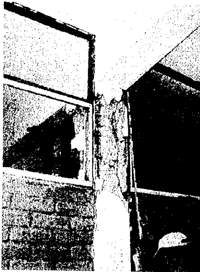
写真 2.1.2-3 柱のせん断破壊 高い腰壁による短柱化 せん断補強筋間隔 30cm
