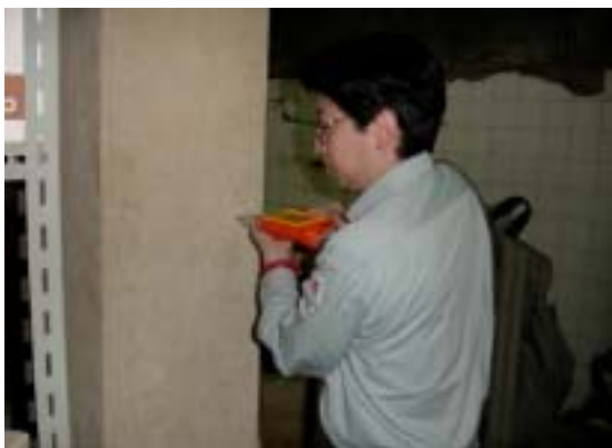
既存建物躯体の強度検査の実施
