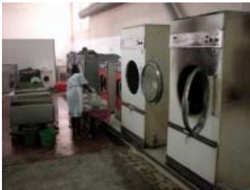
ランドリー：故障のため使われていない機器
