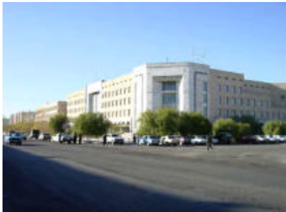
D01 クジルオルダ州立診断センター外観
