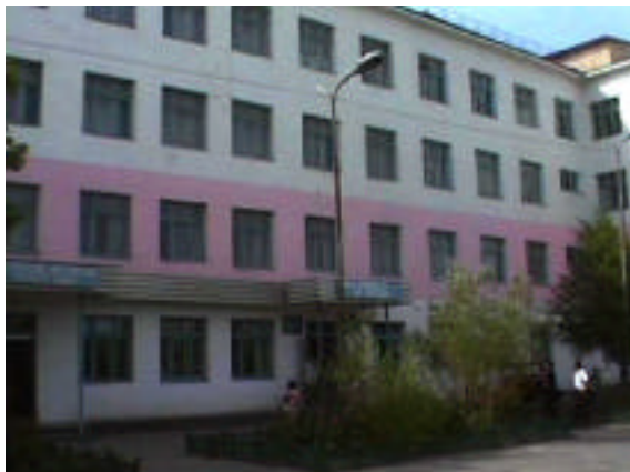
E01 クジルオルダ市産科病院外観
